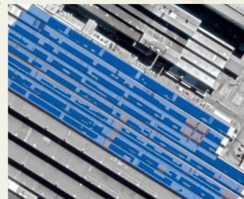
Die Energie der Sonne stärker nutzen: Kariega baut eine Photovoltaik-Anlage auf der Endmontage-Halle.
