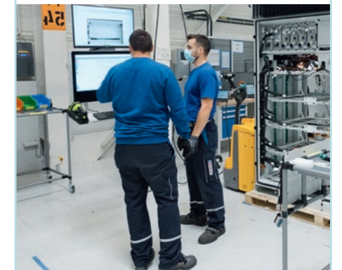
Neue Aufgaben: Kollegen aus der Wärmetauscherfertigung bauen jetzt die flexible Ladesäule.
