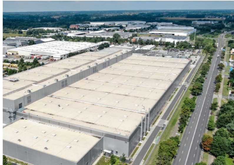
Die neue Halle 32a im Werk 3 West Braunschweig: Hier entstehen die Gehäuse und die MEB-Batteriesysteme selbst.
