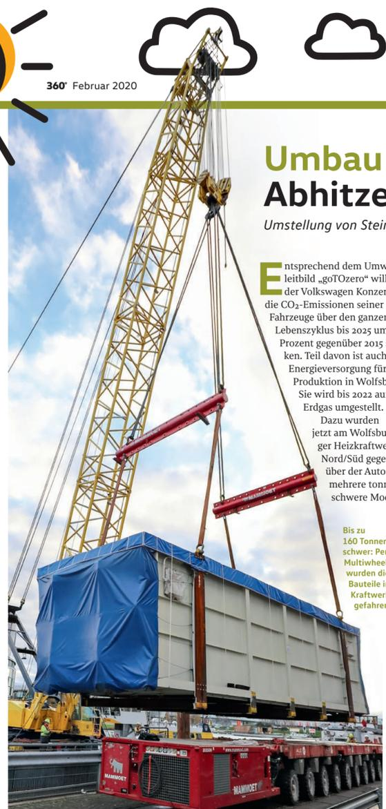
Bis zu 160 Tonnen schwer: Per Multiwheeler wurden die Bauteile ins Kraftwerk gefahren.
