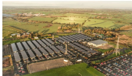
Mitarbeiterparkplätze mit Solardächern bei Bentley Motors in Crewe, England
